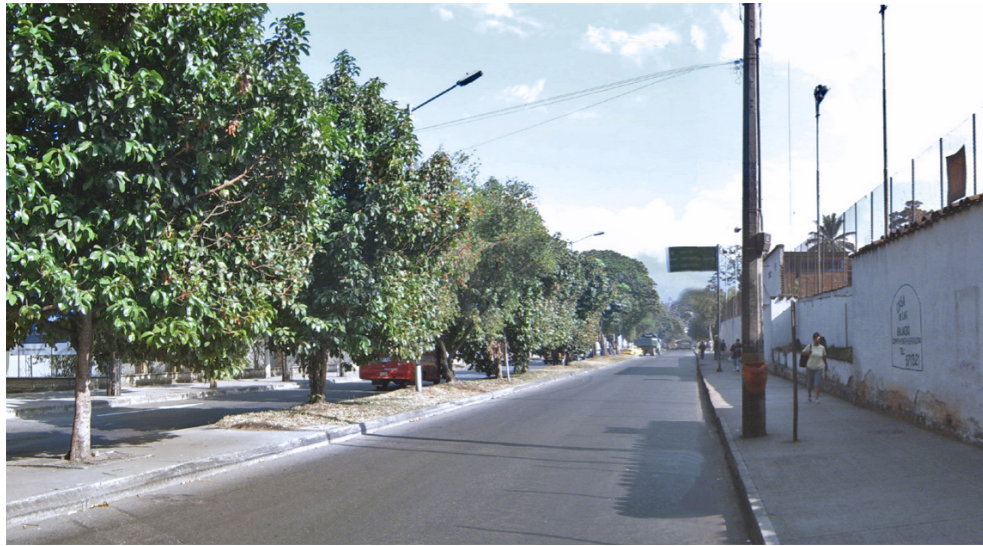
◀ Figura 27: Condición del espacio público y vehicular antes de la intervención T1B. Fuente: EDU 2004.
