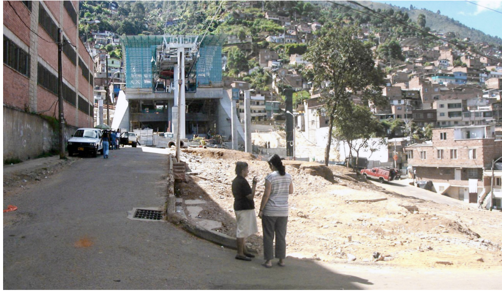
◀ Figura 222: Condición del espacio público y vehicular antes de la intervención de la calle 106 y el Parque de La Candelaria
