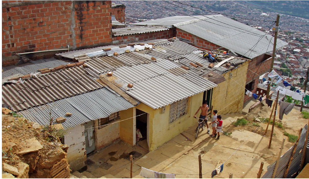
◀ Figura 232: Condición de las casas cercanas a las pilonas del Metrocable antes de la intervención del circuito Calle 106. Fuente: EDU 2004.
