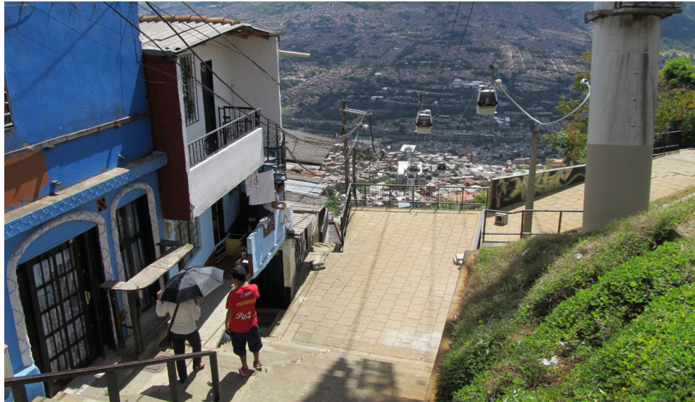
◀ Figura 233: Condición de las casas vecinas al parque mirador después de la intervención del circuito Calle 106. Fuente: EDU 2006.
